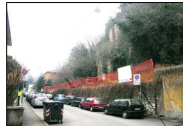
Area degradata prima dell'intervento con auto in sosta selvaggia
